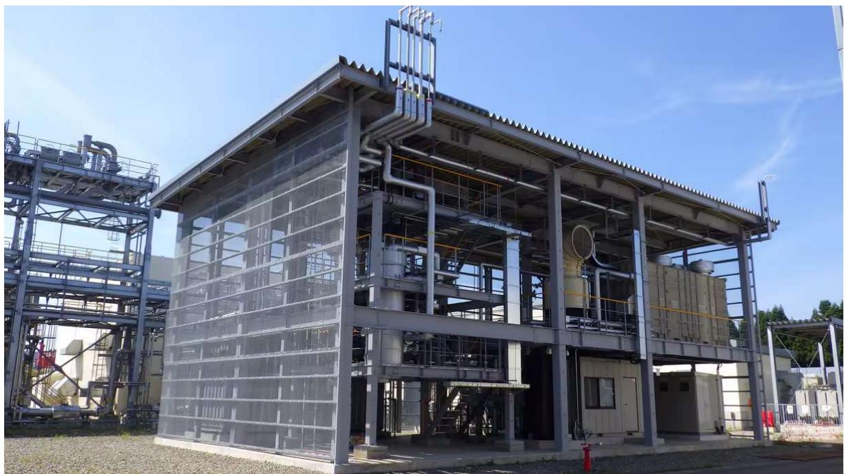
メタネーション装置で実質CO<sub>2</sub>ゼロの都市ガスを製造する
